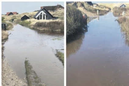
Udfordringerne med det høje grundvandsspejl varierer i Mågedalen. I den nordlige del af Mågedalen har problemet primært været oversvømmet vej - som det ses på fotoet til højre. Med yd er situationen anderledes, da det her er såvel huse som vejen, der er berørt ved et stigende grundvandsspejl - som på fotoet til venstre. Privatfoto.
